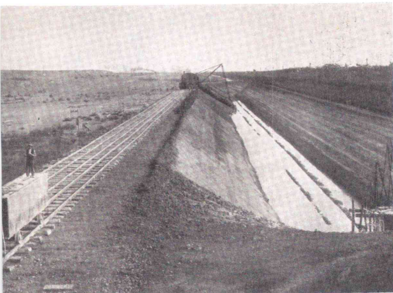
Obras de excavación del canal de Alfonso XIII. Año 1909. Colección particular Marcos Pacheco Morales-Padrón. ©Marcos Pacheco
